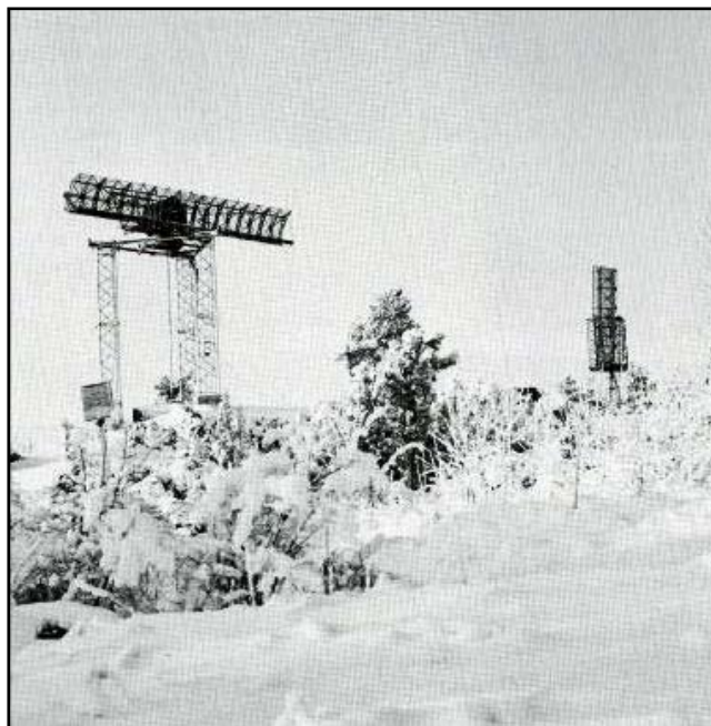
Den sk. ”Radarhöjden ” på F 16 i mitten av 1960-talet hade en fast installerad PJ-21. Till höger en höjdmätare, ”nickande” radarstation, för höjdmätning av mål.
